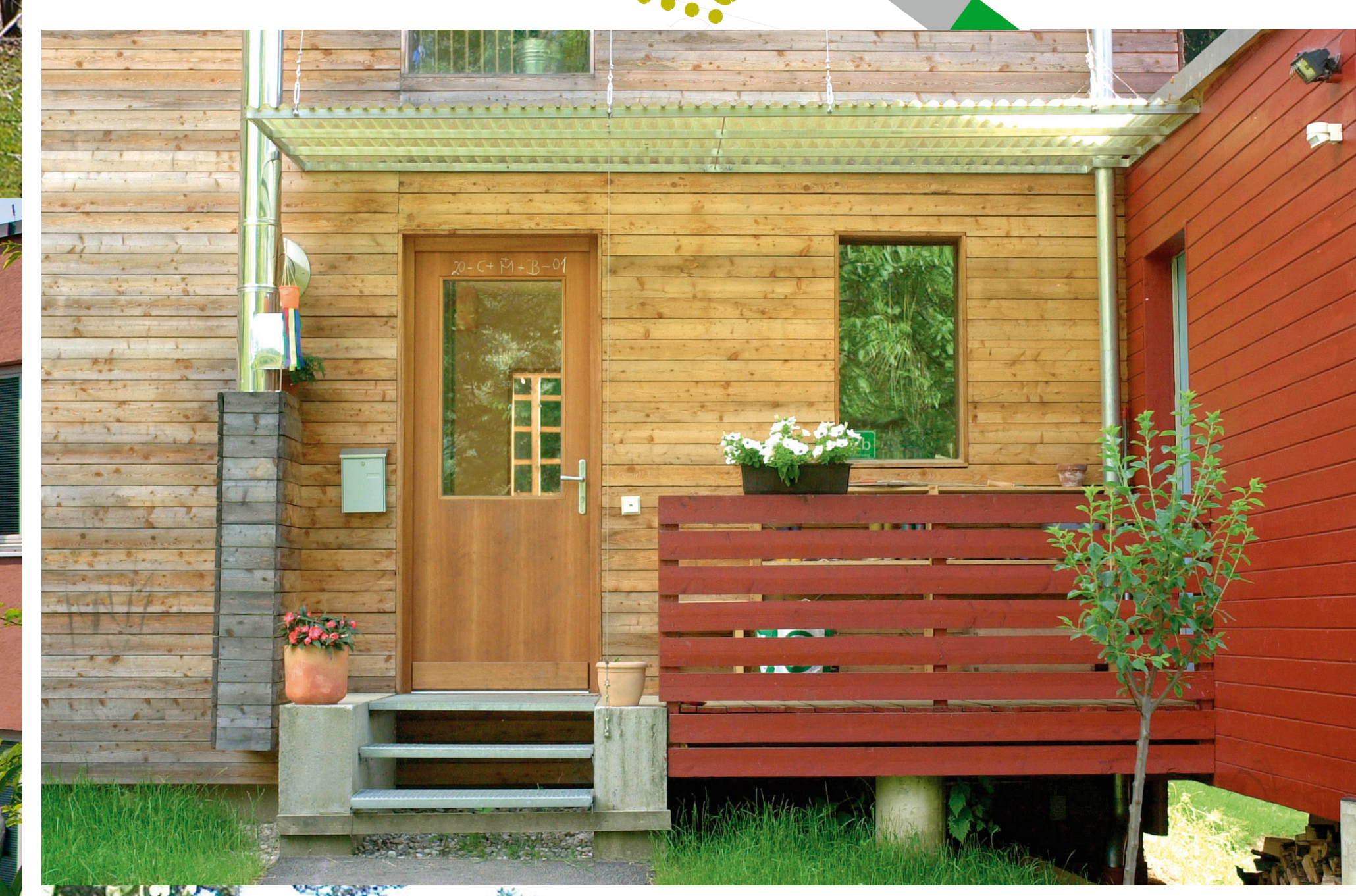
Die Trennung der einzelnen Baukörper von einander erfolgt durch zwischen die Wohneinheiten positionierte Abstellstuppen. Dem Wohn-Ess-Kochbereich im Erdgeschoß ist im Süden jeweils eine Terrasse vorgelagert.
